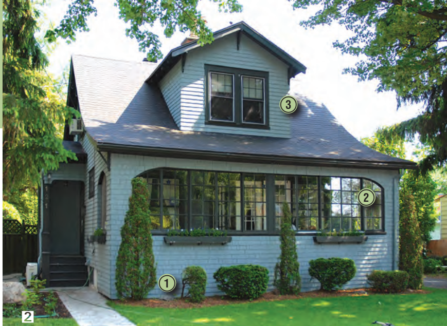
1 Détail d'une maison située chemin Saint-Charles, Greenfield Park.
