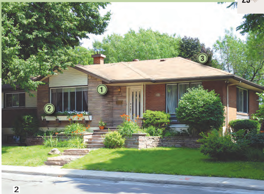
1 Détail d'une résidence de type split-level située rue Queen, Greenfield Park.
