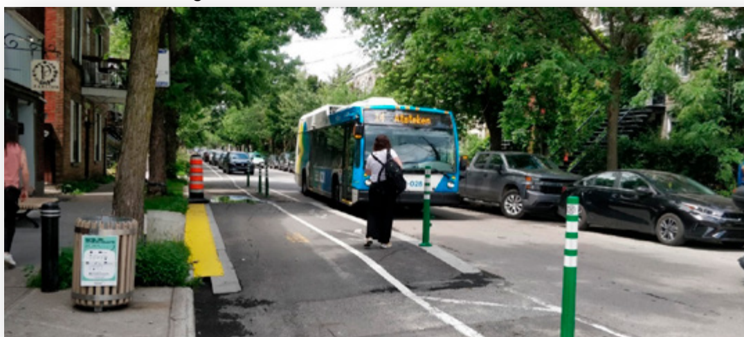
Figure 28 : Quai d'autobus transitoire, Montréal
