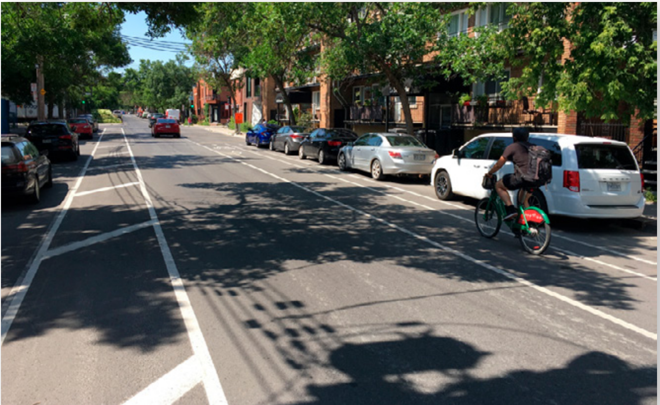
Figure 41 : Zone tampon, rue de la Roche, Montréal
