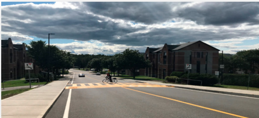
Figure 26 : Passage surélevé, chemin Michel-Sarrazin, Trois-Rivières
