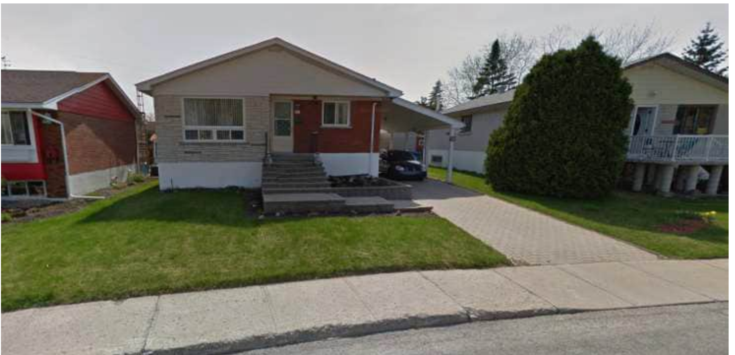
Vue d'ensemble du 971, rue de Parklane avant les travaux (source : Google Streetview, 2015)
