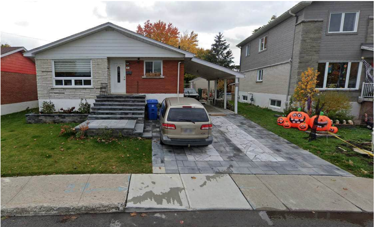
Vue d'ensemble du 971, rue de Parklane après les travaux (source : Google Streetview, 2020)
