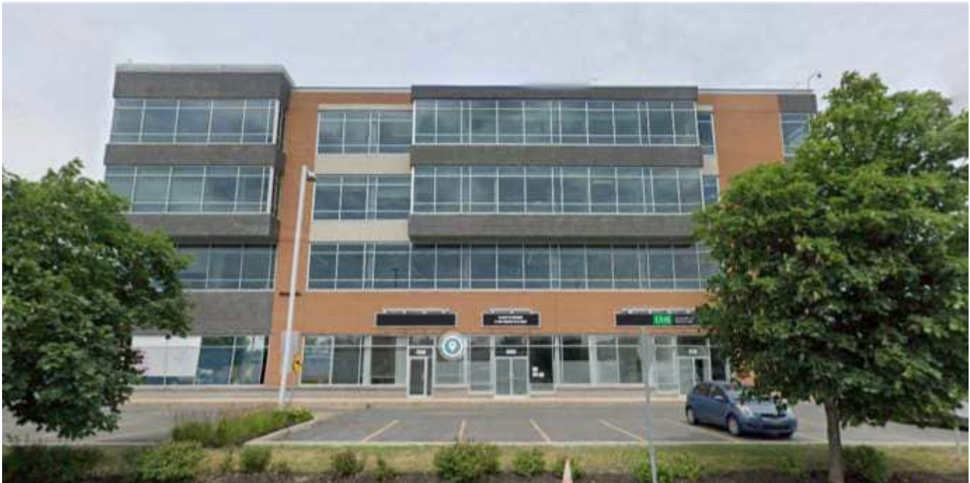
Enseigne dérogatoire sur la façade du bâtiment donnant sur la rue Mary
