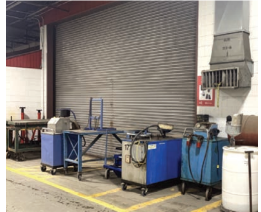
Exemple d'équipements localisés de l'autre côté d'une porte coupe-feu et qui ne sont plus accessibles sans l'aide d'une manœuvre.
