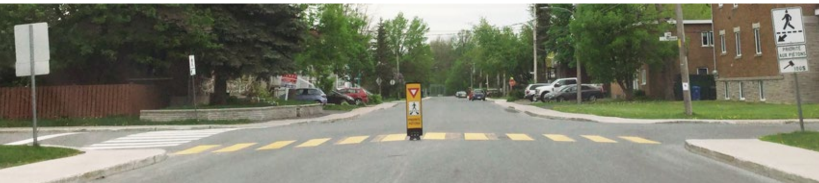
Figure 5. Passage pour piétons non contrôlé avec balise centrale
