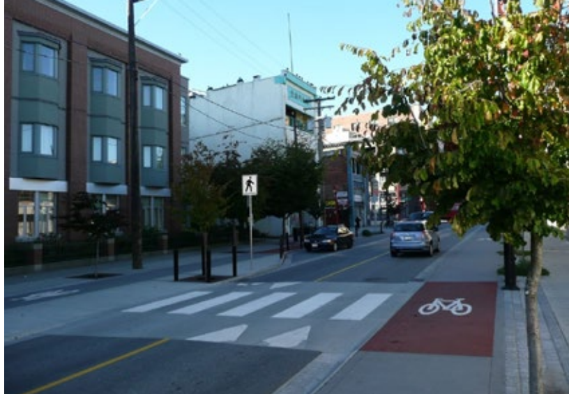
Figure 13. Passage pour piétons surélevé en section courante
