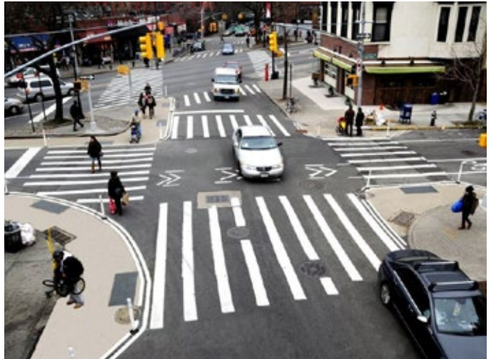
Figure 11. Saillies de trottoir mises en œuvre avec des aménagements légers Source : NACTO
