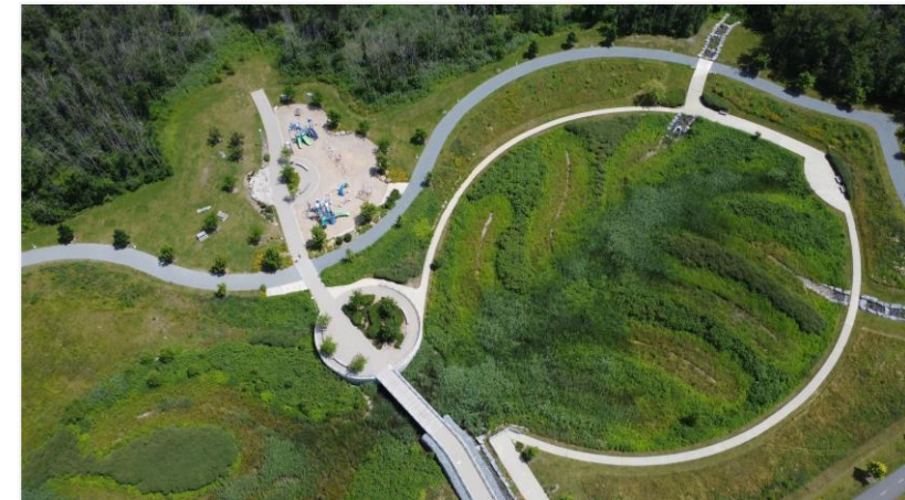
Parc des Semis et bassin de rétention
