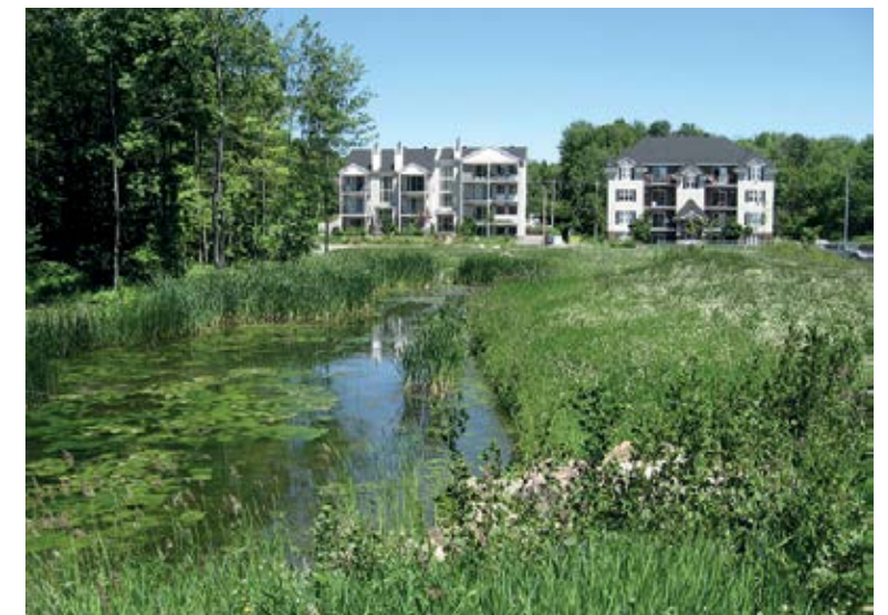
BASSIN DE RÉTENTION (PARC SCHULZ, SAINT-JÉRÔME, QC) Source : AAPQ, 2010
