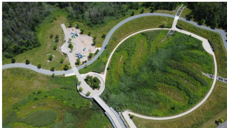
Bassin de rétention de surface – Parc des Semis
