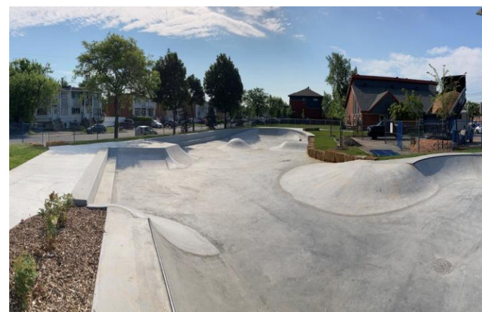
Bassin de rétention de surface en béton - Skatepark dans le parc Pierre-et-Bernard-Lucas
