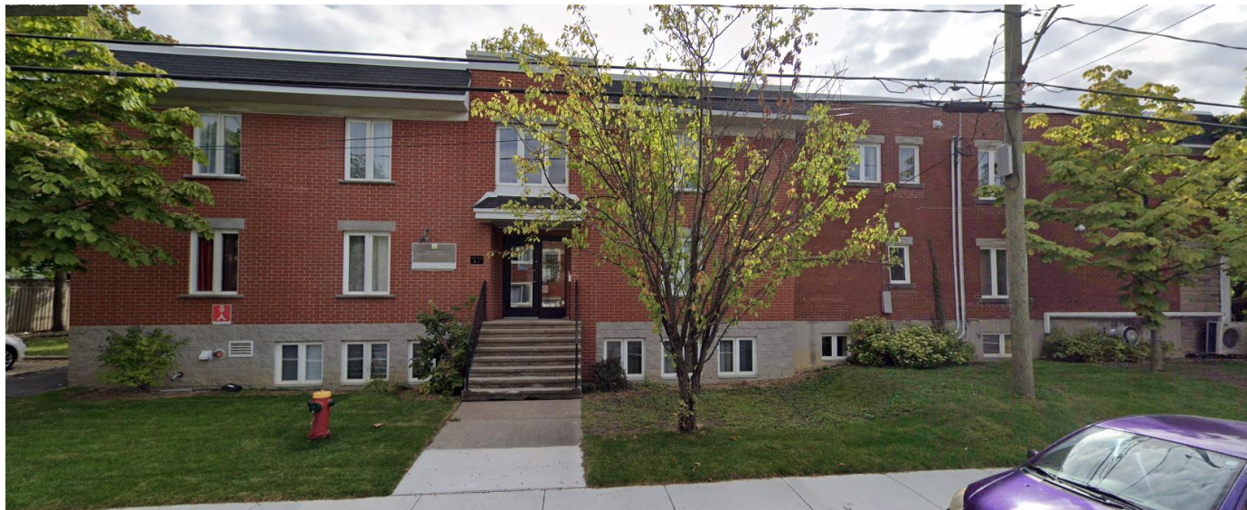
Façade du bâtiment sur la rue Le Moyne Ouest
