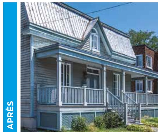
Agrandissement, remplacement du parement et des ouvertures, et restauration de la galerie en retour d'équerre, lesquels font partie des travaux de sauvetage de l'immeuble.
