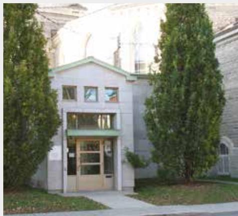
Reconstruction du parvis au centre, remplacement des portes selon le modèle d'origine et construction d'un accès universel du côté de la rue Saint-Élizabeth.
