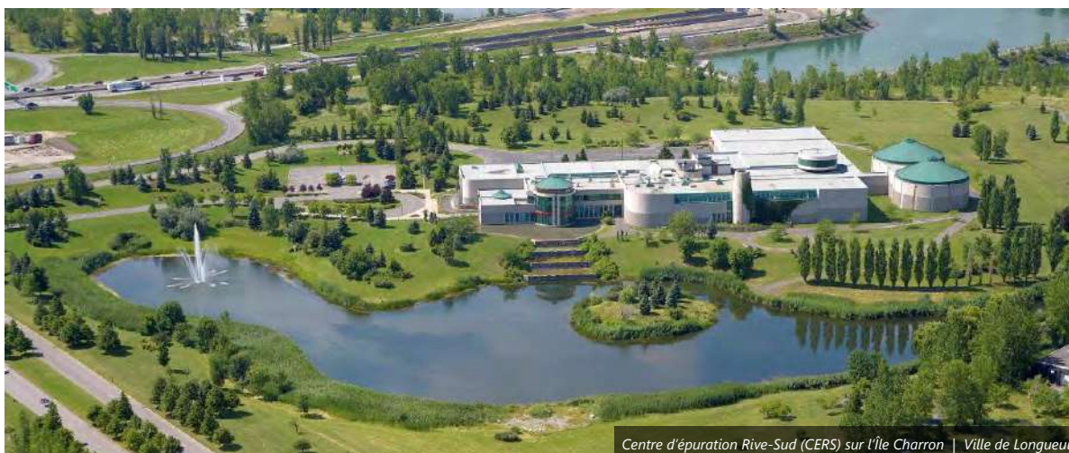
Centre d'épuration Rive-Sud (CERS) sur l'île Charon | Ville de Longueuil
