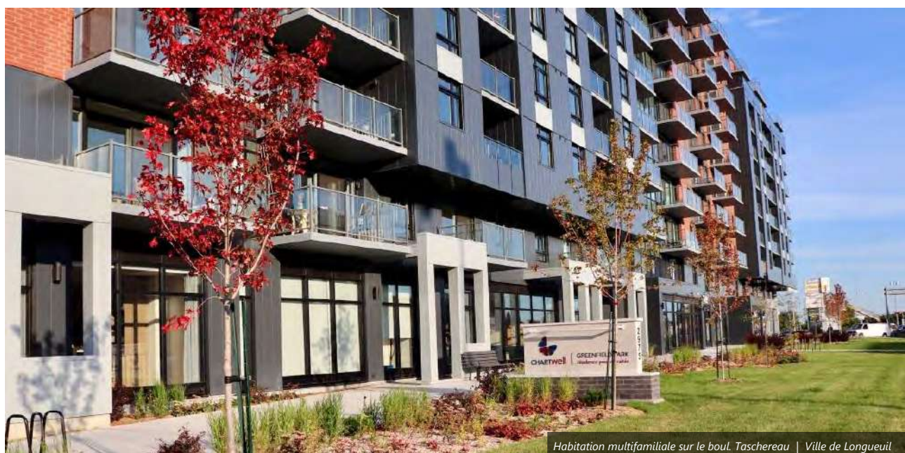
Habitation multifamiliale sur le boul. Taschereau | Ville de Longueuil
