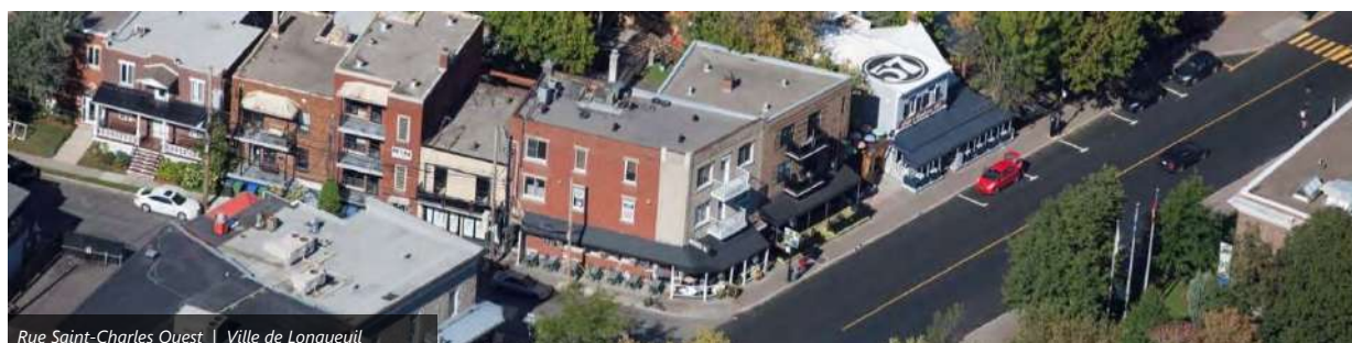
Rue Saint-Charles Ouest | Ville de Longueuil
