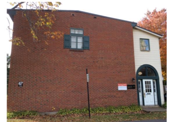
Vue latérale droite de l'édifice
