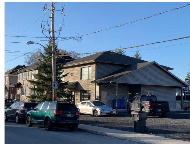
2394, rue Lincourt Espace en marge latérale droite à agrandir
