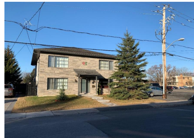
2394, rue Lincourt - Façade avant
